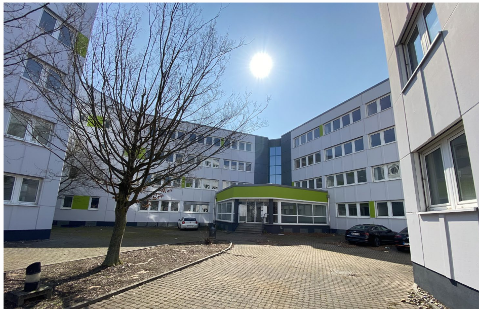
Peter-Sander-Straße 30, 55252 Wiesbaden (vorher)
